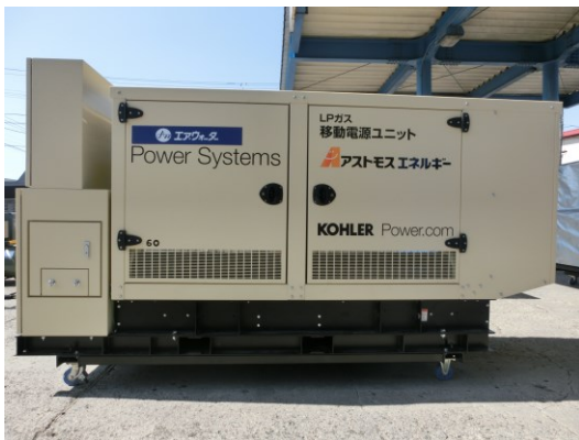
【ユニット外観】
